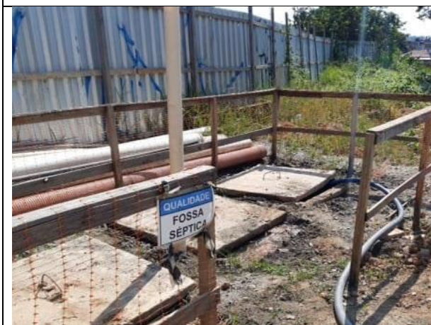
Foto 5: Limpeza da fossa séptica (22/04/2022)
